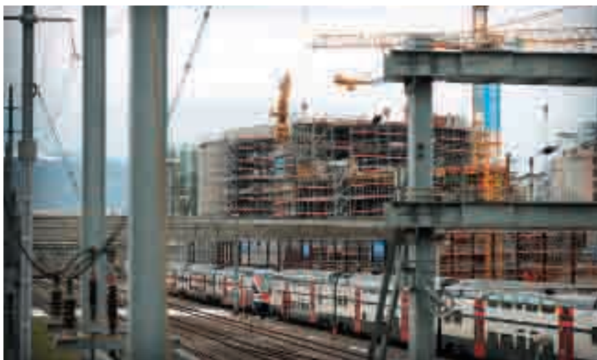
Construction site of the Maison de la Paix in February 2013 (© Laurent Guiraud/Tribune de Genève)
